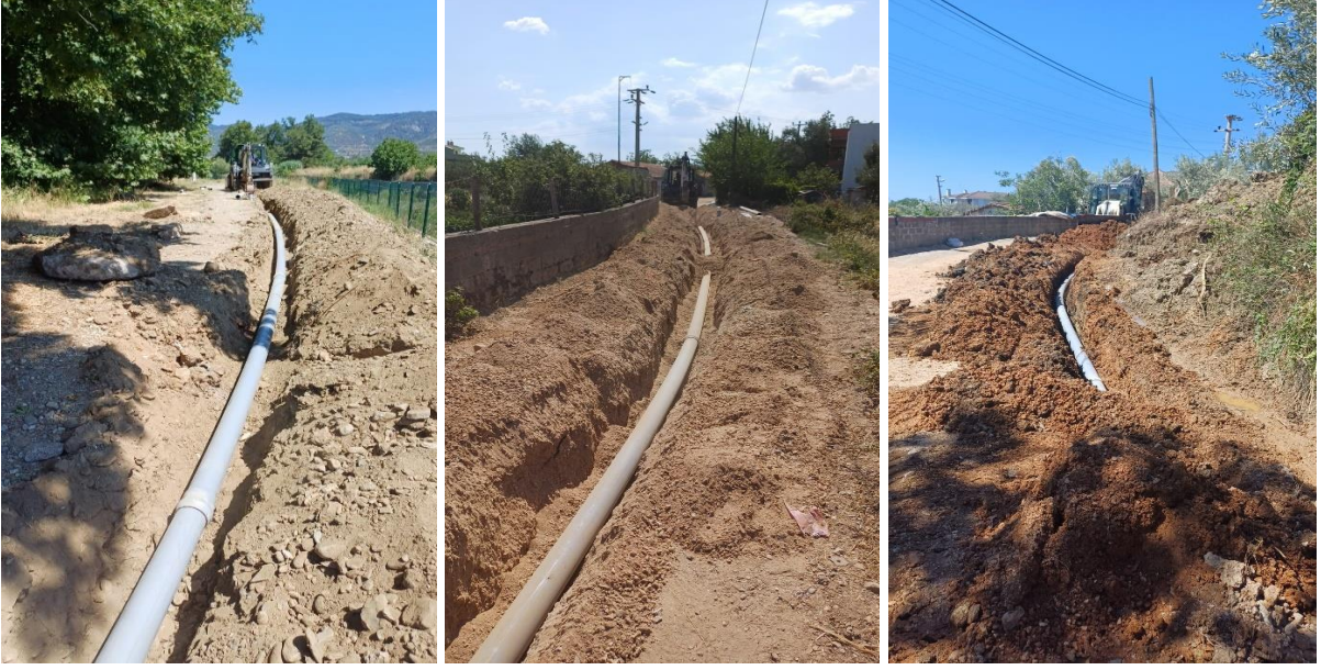
Temiz su hattı döşemesi
