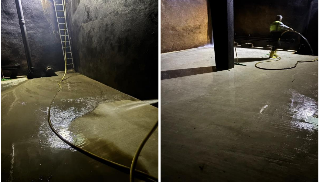
İçme suyu depo temizliği
